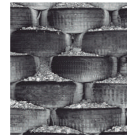
Construcción de Taludes Obras Civiles
